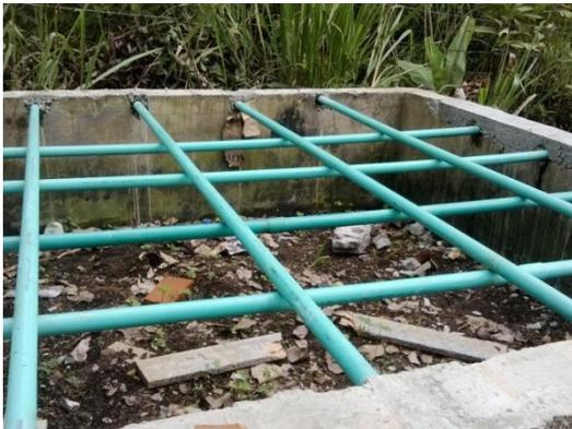
Se colocó el tanque, pero al realizar la prueba de llenado las varillas se pandearon y utilizando los implementos comprados se va a cambiar de sitio.
